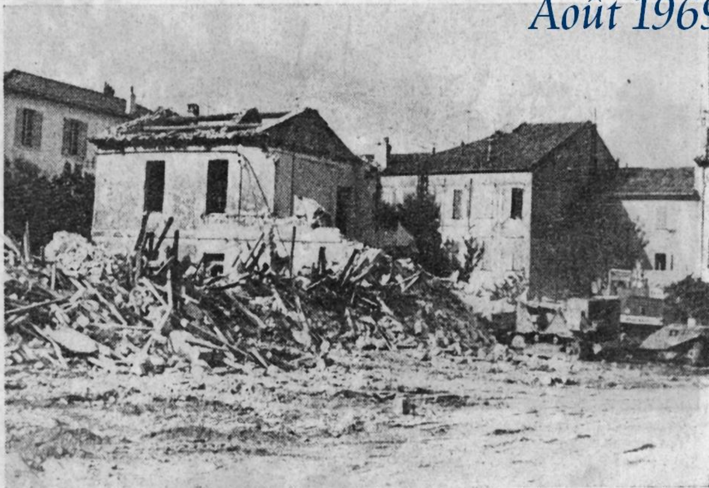
De la douane il ne restait hier plus que des ruines.
